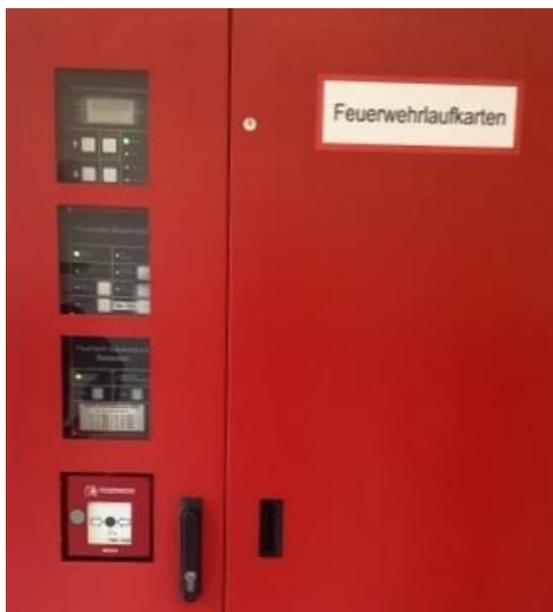
Sollte dies nicht möglich sein, ist das FGB in einem eigenen Gehäuse unterzubringen. Das FGB sollte in einer Einbauhöhe von 1500 (+100-200)mm montiert werden (gemessen von der Standfläche des betätigenden bis Mitte Bedienfeld), Das Gehäuse ist mit der Schließung der Feuerwehr Bonn zu verschließen.
