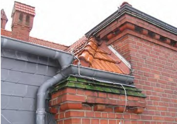
**Abbildung 3: Lüftungsplatte zum Verschluss der Dachplatten**
