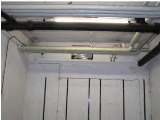
**Abbildung 14: normales Gitterkellerfenster, mit Steinwolle abgedeckt**
