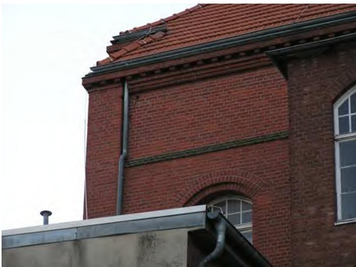
Abbildung 2: Beschädigung in der Fassade re. Von Regenrinne unterhalb Dachzierleiste
