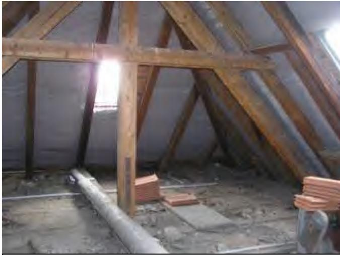
**Abbildung 9: Blick auf Unterspannbahn der Dachkonstruktion**
