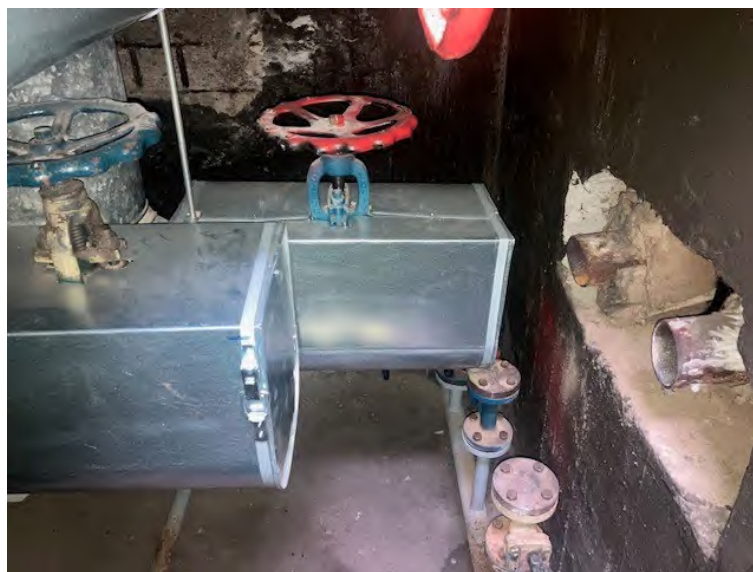
Abbildung 3 Foto des zurückgebauten Fernwärmeanschlusspunktes der ehem. Poliklinik
