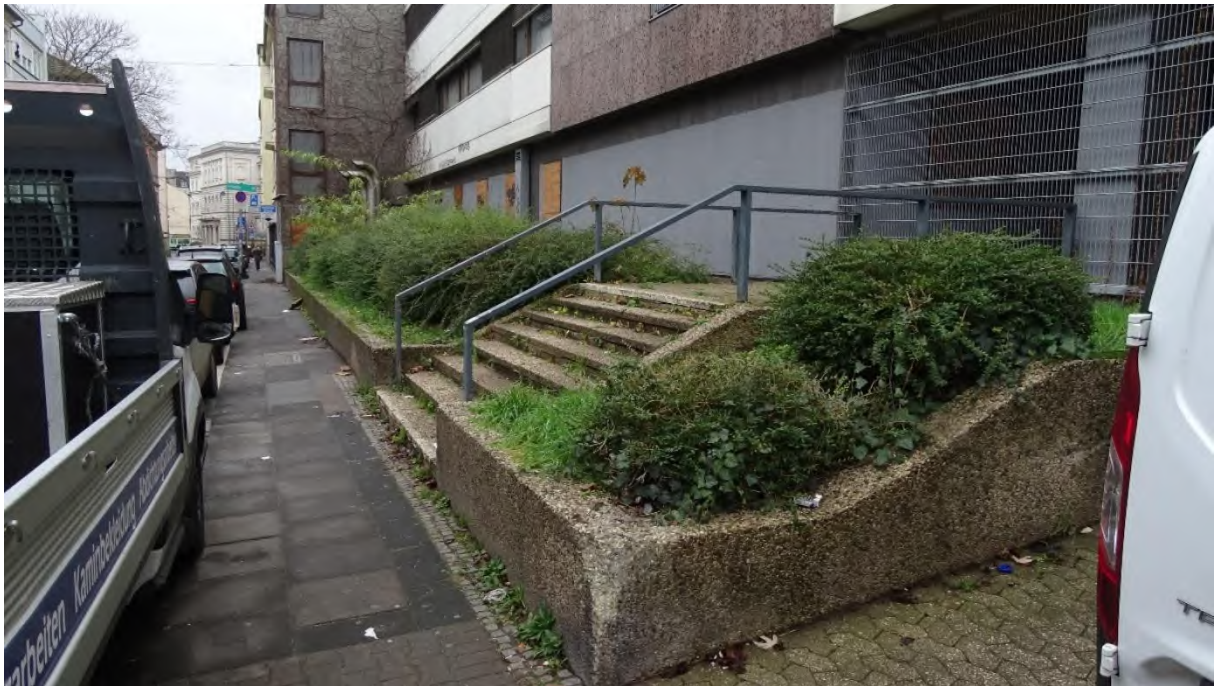
Anlage 3: Fotodokumentation: Wilhelmstraße – Bauteil A
