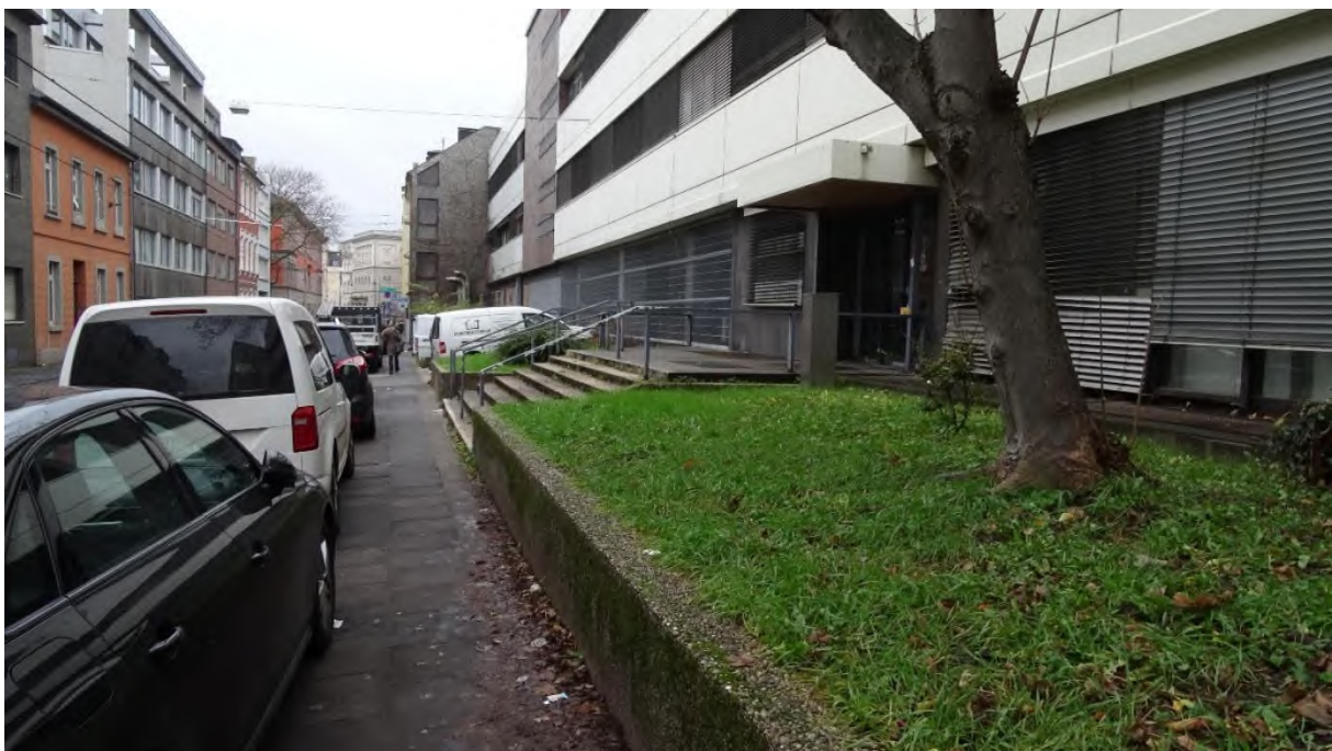
Anlage 2: Fotodokumentation: Wilhelmstraße – Bauteil A
