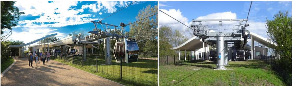
Abbildung 8: Offene Stationsbauweise – Beispiel Berlin [IB Schweiger]
