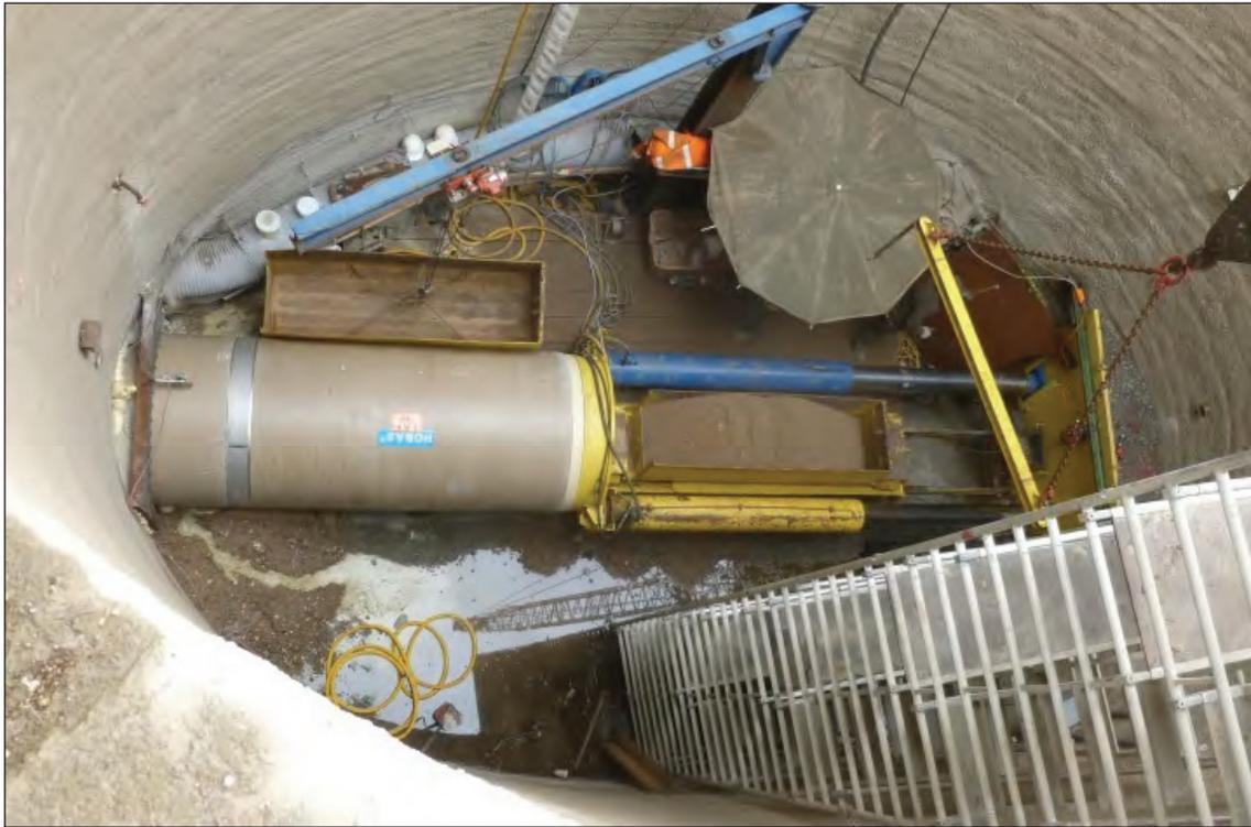
Abbildung: Startbaugrube Rohrvortrieb
