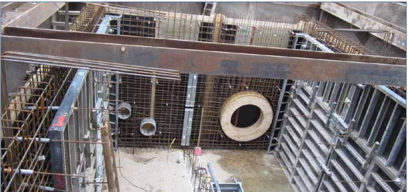
Baugrube S8: Entlastungsbauwerk mit Schal- und Bewehrungsarbeiten
