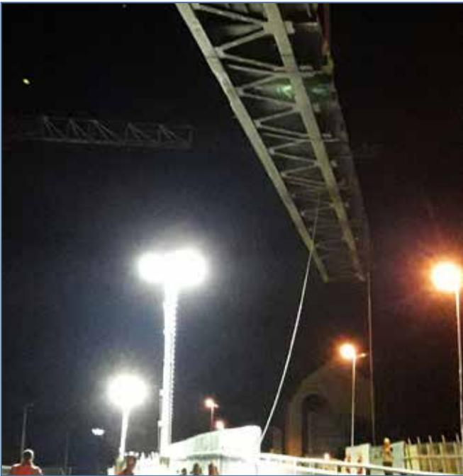
In drei bereits abgeschlossenen Teilbaumaßnahmen erfolgte der halbseitige Rückbau des Brückenüberbaues (Ostseite) und der Rückbau der östlichen Rampenstützwände und teilweise des nördlichen Widerlagers der Viktoriabrücke. Des Weiteren wurden die Rampenwände auf der Ostseite neu hergestellt.
