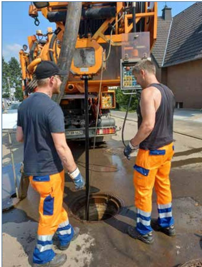
Kanalreinigungsarbeiten mit einem Wasseraufbereiter nach starkem Schlammeintrag
