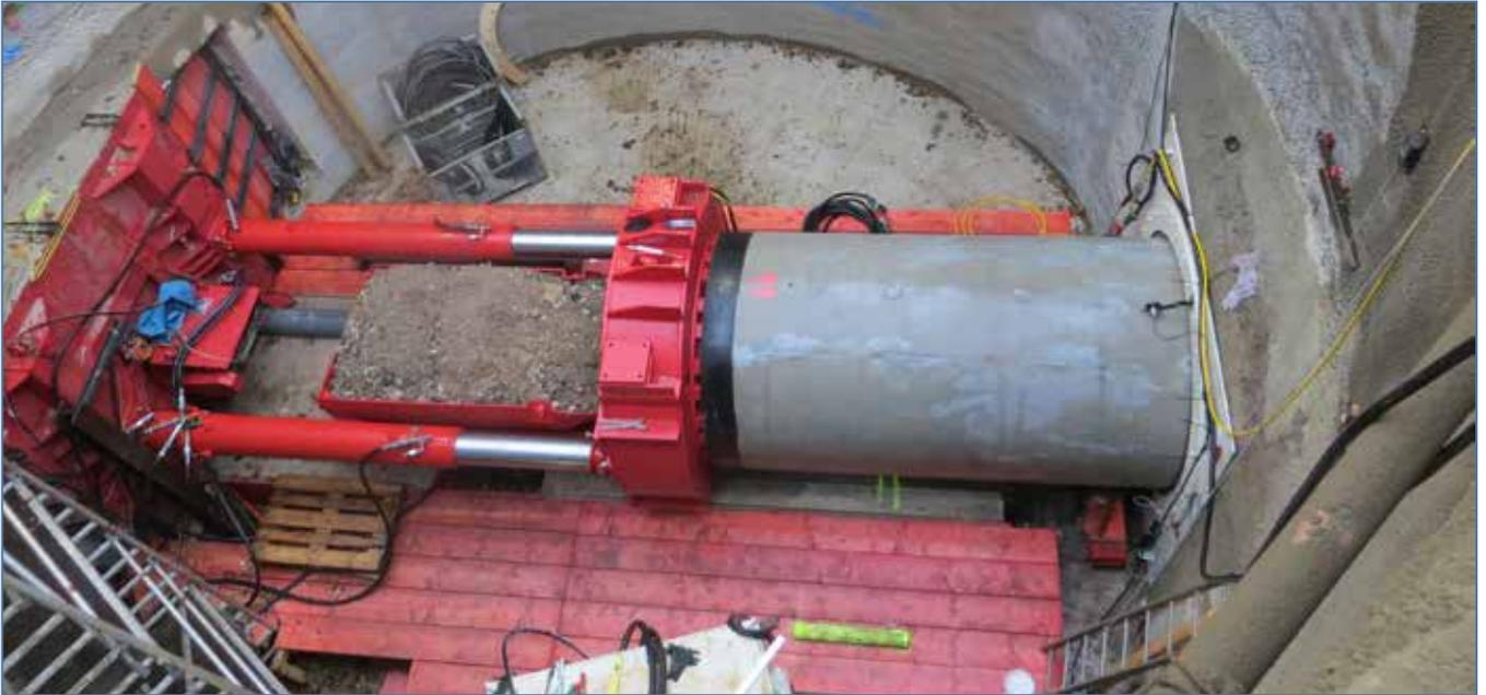
Doppelstartbaugrube: Vortriebsanlage für Stahlbetonrohrkanal DN 1600 VT
