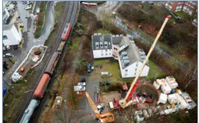
Doppelstartbaugrube S3 im Platanenweg für den Rohrvortrieb in Richtung Zielbaugrube Kreuzungsbereich Auguststraße/Siebenmorgenweg
