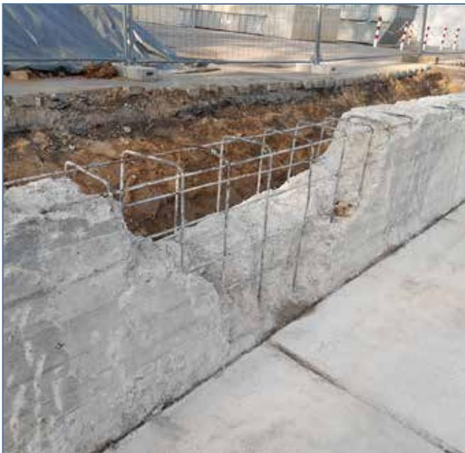
Betonausbruch an Außenwand des RÜB 3
