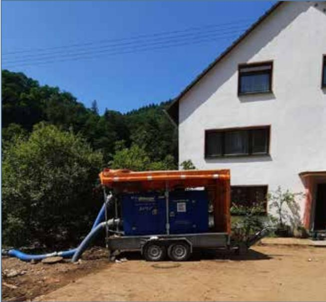
Vakuumpumpe im Einsatz zur Abwasserumleitung
