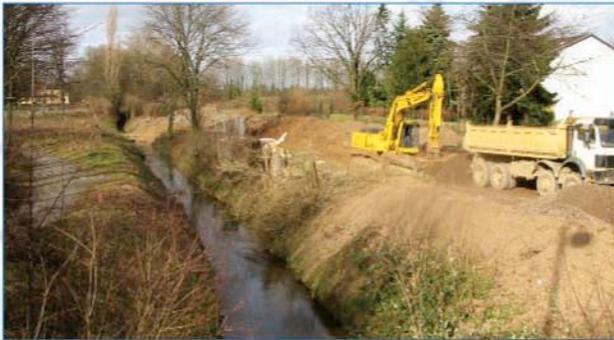
Entfernung der Betonschalen und Aushub des Erdreiches.
